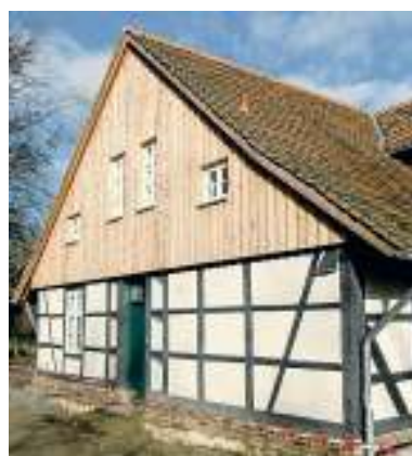
Haus Entenfang gegen Ende der Sanierung im Januar 2015. Foto: privat
