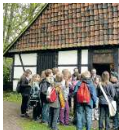
Haus Entenfang vor Beginn der Sanierung im Sommer 2011. Foto: Mentasti
